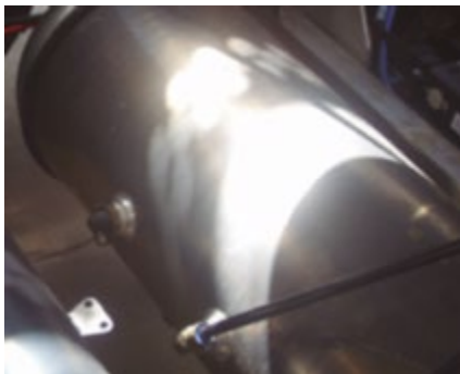
FIGURA 10: Sistema automático de purga
