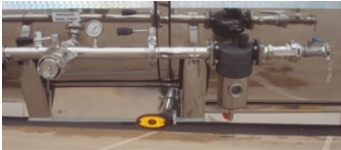
FIGURA 25: Colector de presión con filtro
