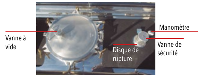
FIGURE 37: Vanne vide + vanne de sécurité + disque de rupture
