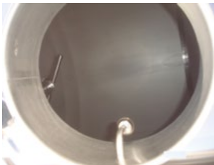
FIGURE 23: Système de nettoyage pour col avec capteur de niveau de remplissage
