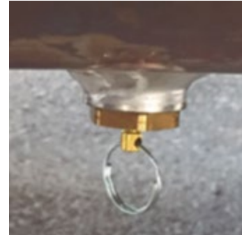
FIGURE 9: Système de purge manuelle
